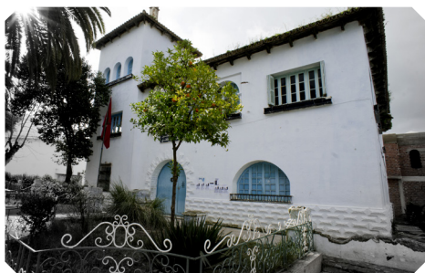
Oficina Municipal de Urbanismo, de 1944. Fue la vivienda del interventor general y responde al planeamiento inicial de casa de ciudad jardín.
