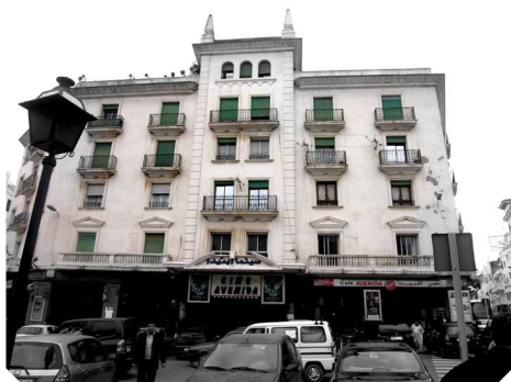
Cine Avenida en Plaza al-Adala.
